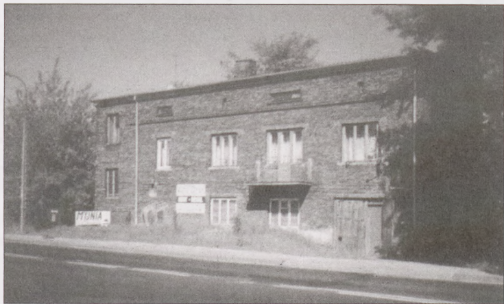
Budynek dawnej piekarni Elsnera.
