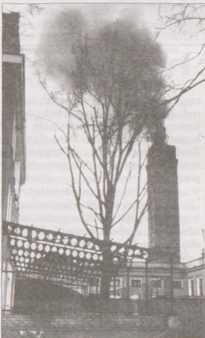
Zdjęcie z ubiegłego roku - dymi kotłownia przy ul. Nurzyńskiej
