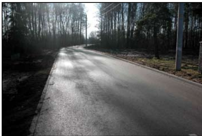
Zmodernizowana ulica Akacjowa (Maryłka-Prace Małe)
